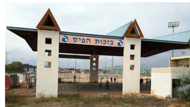
Dětské hřiště ve Sderotu chráněné proti střelám. Vpravo dole vchod do podzemního krytu
