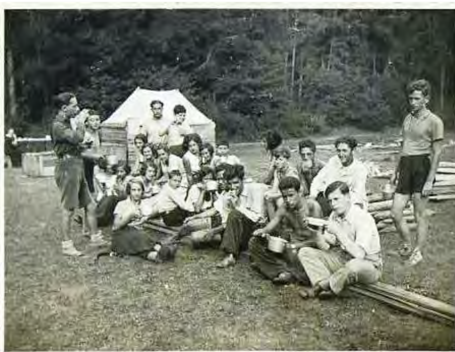
Stavba tábora Bejtaru na Mácově mlýně. První polovina 30. let dvacátého století [soukromý archiv MUDr. Jana Greblera]
